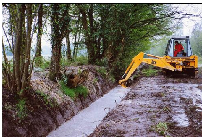
รูปที่ ๗.๓๑ การขุดแต่งร่องน้ำโดยใช้ปังกี่หลัง
