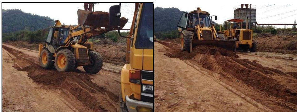
รูปที่ ๓-๓ การใช้รถตักหน้า-ขุดหลังตักวัสดุที่เหลือจากการตัดระดับ
