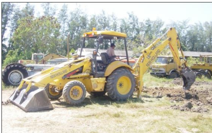
รูปที่ ๗-๑๑ การจอดเครื่องจักรเพื่อใช้ขุดขุดหลัง สำหรับพื้นที่ดินอ่อน
