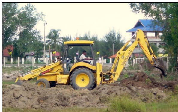
รูปที่ ๗-๒๑ การปรับพื้นที่โดยใช้ปู้งกีหลัง
