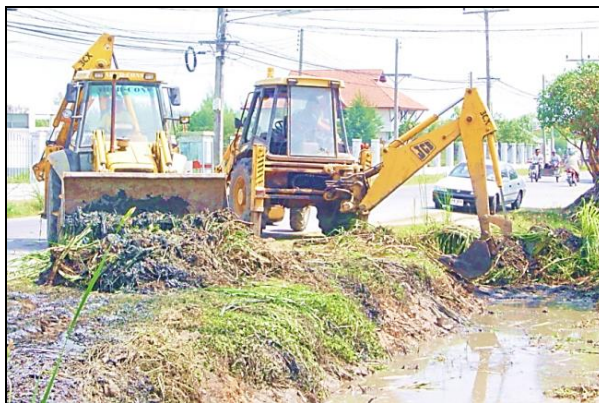
รูปที่ ๒-๗ การชุดแต่งร่องน้ำโดยใช้ปู้งก็หลัง แล้วใช้ปู้งก็หน้าตักวัชพืชใส่รถบรรทุก
