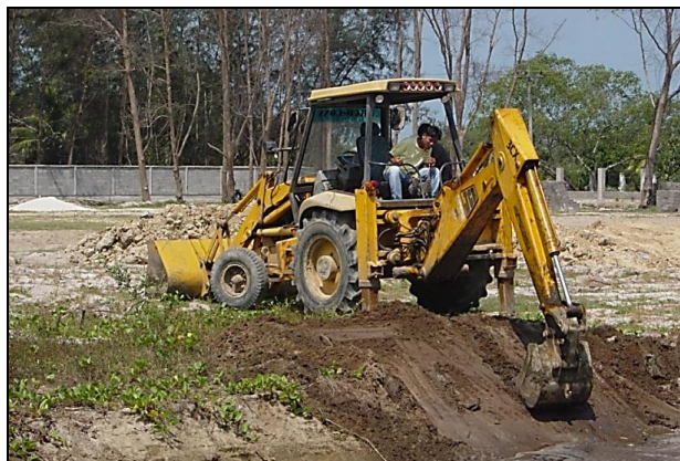
รูปที่ ๗-๓๓ การแต่งขอบสระน้ำ โดยจอดเครื่องจักรในแนวตั้งฉากกับพื้นที่ทำงาน
