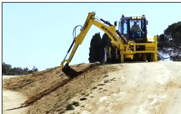
รูปที่ ๗-๓๔ การแต่งลาดคันทางโดยจอดเครื่องจักรในแนวขนานกับพื้นที่ทำงาน
