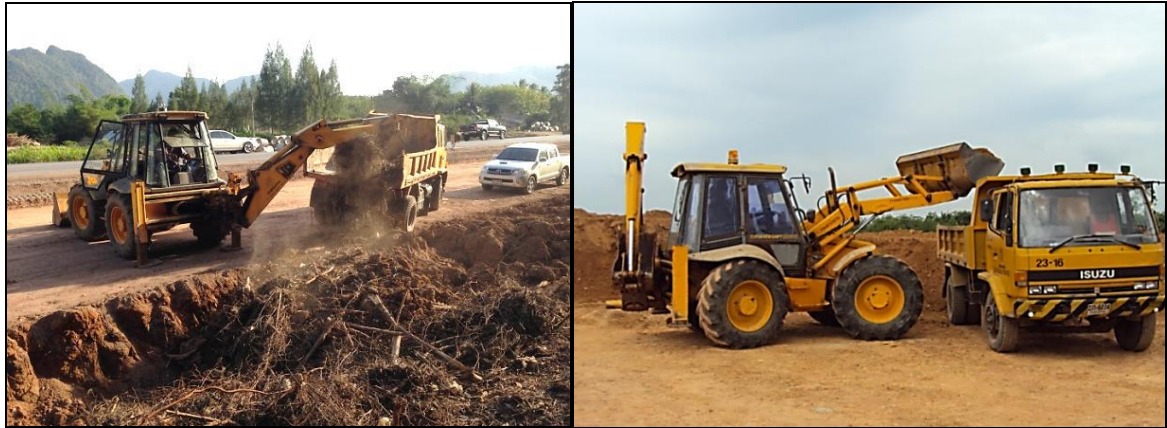
รูปที่ ๓-๒ การใช้รถตักหน้า-ขุดหลังตักวัสดุจากกอง stock pile
