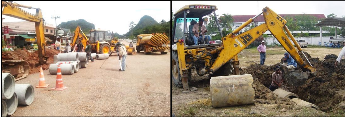
รูปที่ ๓-๗ การใช้รถตัดหน้า-ชุดหลังวางท่อระบายน้ำ
