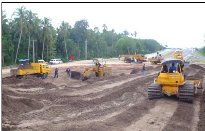
รูปที่ ๑-๑ การใช้เครื่องจักรกลในพื้นที่งานก่อสร้างทาง
