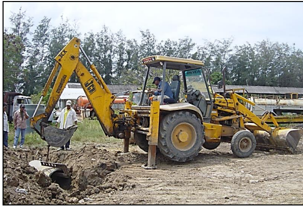
รูปที่ ๗.๓๒ การขุดแต่งร่องน้ำโดยใช้ปู้งก็หลัง แล้วใช้ปู้งก็หน้าตักกวสตุไสรถบรรทุก
