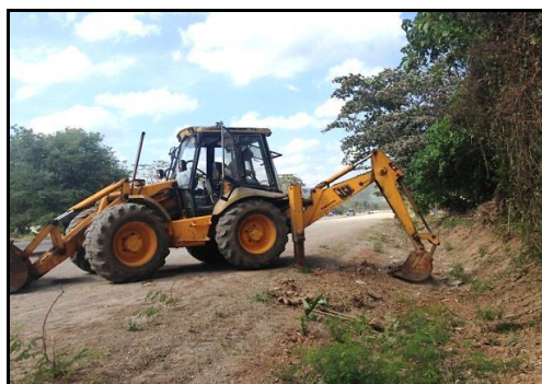
รูปที่ ๓-๘ การใช้รถตัดหน้า-ชุดหลังแต่งลาดคันทาง
