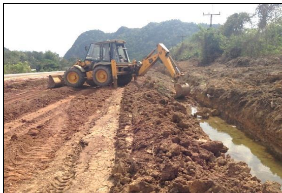
รูปที่ ๓-๕ การใช้รถตัดหญ้า-ขุดหลังขุดร่องน้ำใหม่
