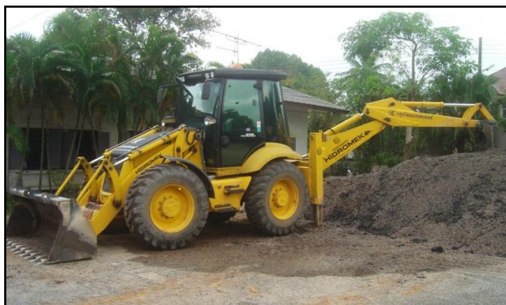
รูปที่ ๗-๑๒ การจอดเครื่องจักรเพื่อใช้ขุดขุดหลัง สำหรับพื้นแข็งหรือพื้นที่ต้องระวังการชำรุดเสียหาย
