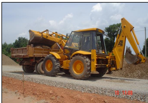
รูปที่ ๗-๒๗ การตัดวัสดุใส่รถบรรทุก
