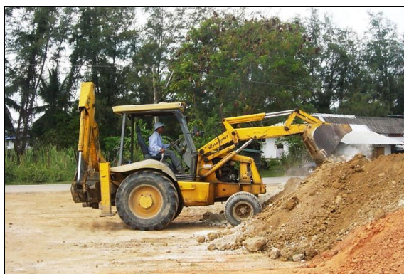
รูปที่ ๗-๒๕ การรวมกองวัสดุโดยใช้ปั๊มก็ด้านหน้า
