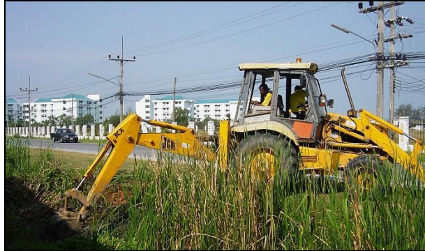
รูปที่ ๓.๔ การใช้รถตัดหญ้า-ขุดหลังขุดลอกร่องน้ำเดิม
