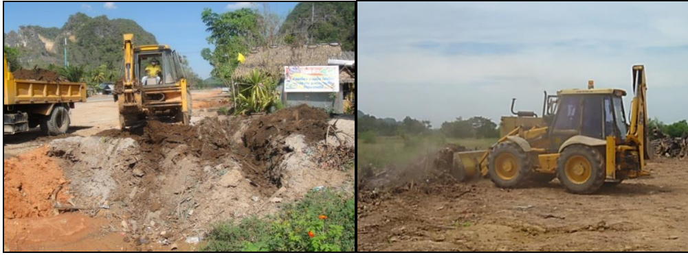
รูปที่ ๓-๑ การใช้รถตักหน้า-ขุดหลังทำงานปรับพื้นที่และถางป่าขุดต่อ
