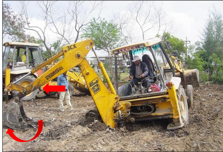
รูปที่ ๖-๒ การใช้ปั๊มกีฬาล้างช่วยดันรถตัดหญ้า ขุดหลังขึ้นจากหล่ม
